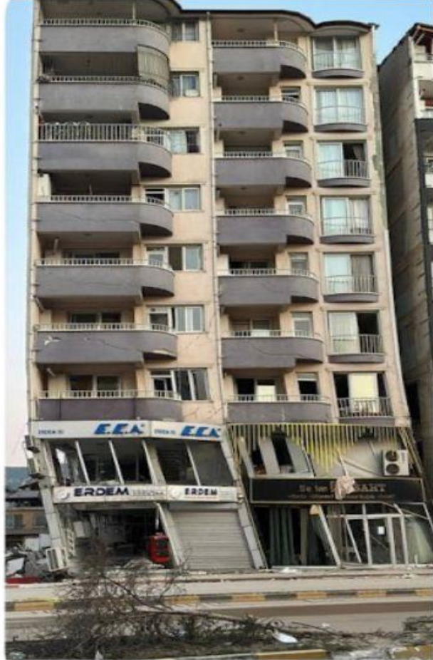
Şekil 4. Yumuşak kat düzensizliği 2D gösterimi ve gerçek yapıda gösterimi (Gençoğlu,2012)
