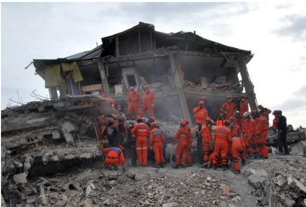
Şekil 1. Kahramanmaraş depreminde asmolen döşemeye sahip yıkılmış konutlar.
