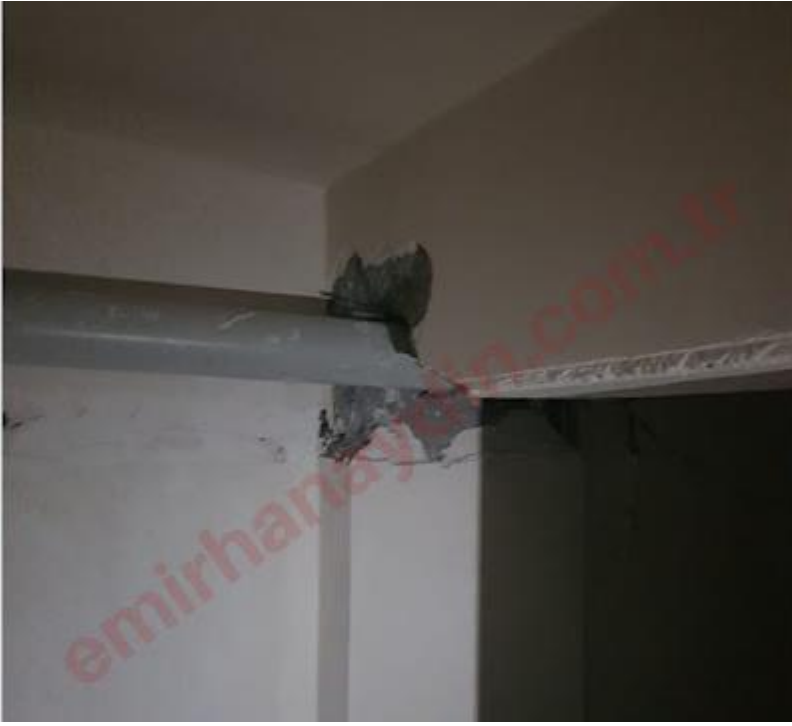
Şekil 7. Tesisat borusu için kesilen kiriş
