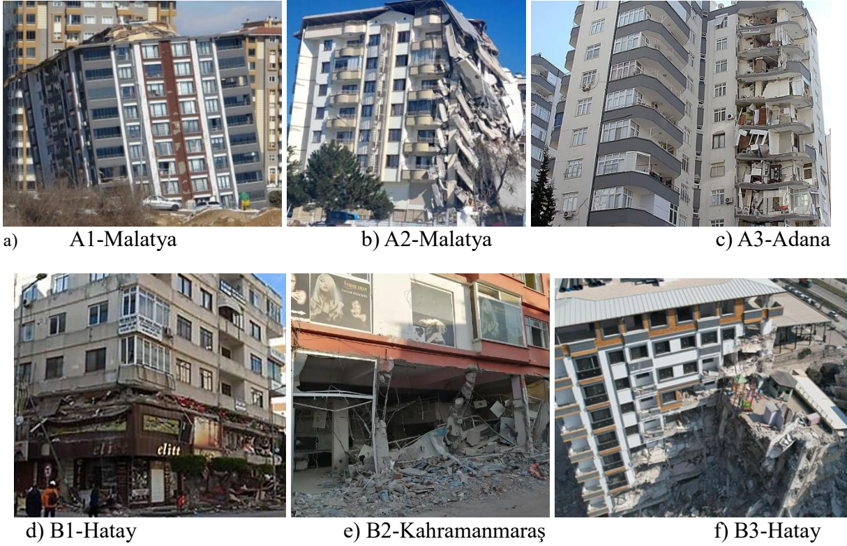
Şekil 2. Yapısal düzensizlikler nedeniyle hasar alan yapı örnekleri
