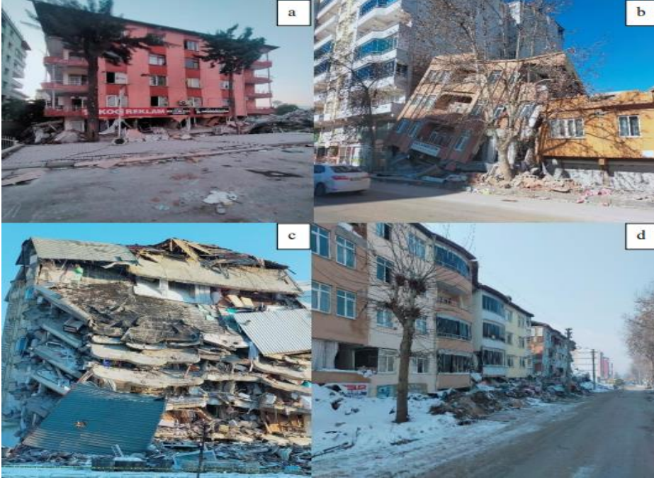
Şekil 1. Zemin katı ticarethane olan, yumuşak kat kaynaklı yıkımlara örnekler (a: Hatay, b: Adıyaman, c: Malatya, d: Kahramanmaraş). (AFAD Kahramanmaraş Depremleri Raporu, 2023)
