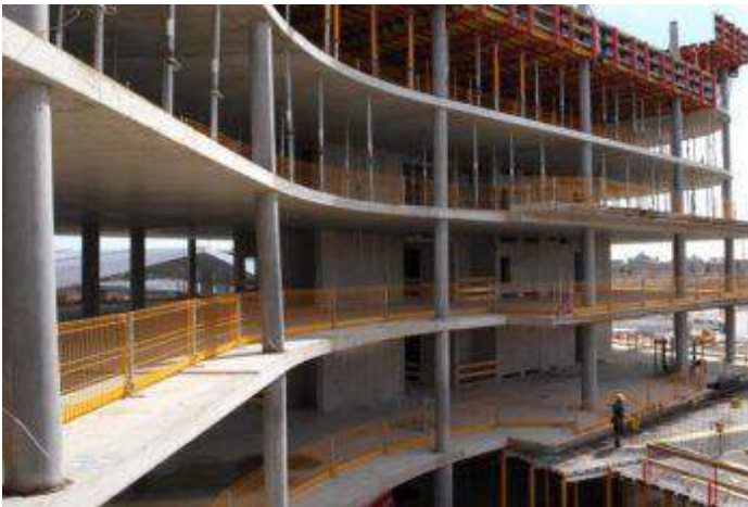
Şekil 3. Plak döşeme (Sanal şantiye,2022)
