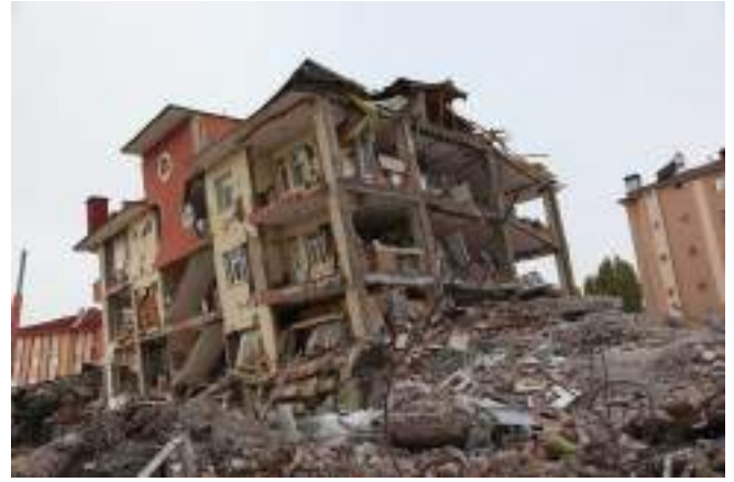
Şekil 2. Depremde asmolen döşemeli yapıların yıkılması (AFAD,2023)
