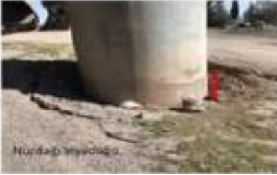
Şekil 6. Sıvılaşma Kaynaklı Bina Hasarları (deprem arařtırmaları sanal konferansı)
