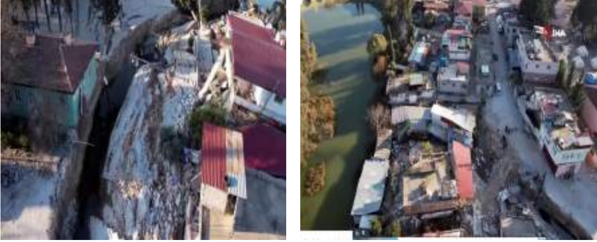
Şekil 5 Hatay Antakya Demirköprü köyünde yer hareketinin binalara etkisi
