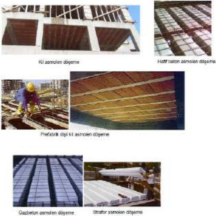
Şekil 9. Asmolen döşeme dolgu türlerinin kullanımı (sanal şantiye, 2020)
