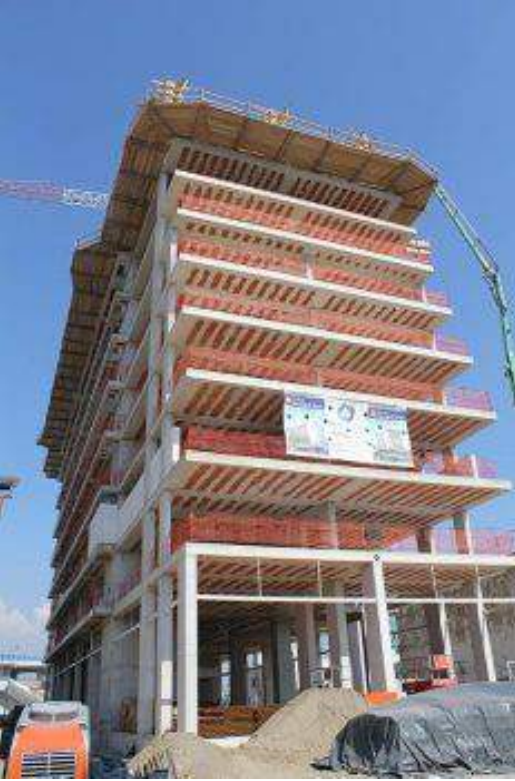
Şekil 6. Asmolen döşeme (sanal şantiye, 2022)
