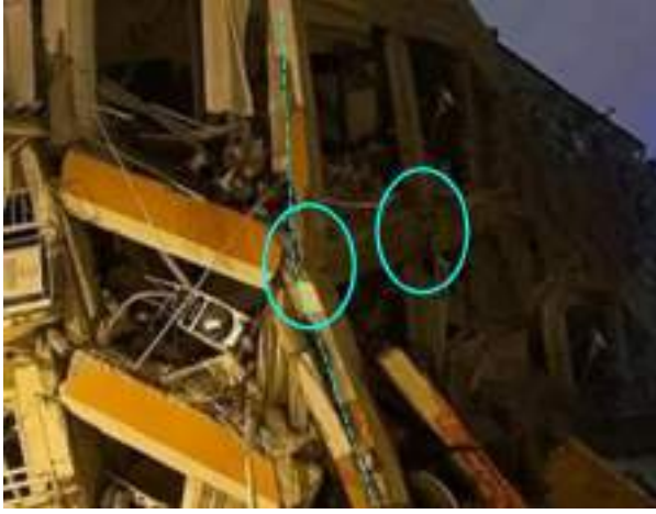
Şekil 13. Depremde yıkılan bir bina (Elbistan/Kahramanmaraş 2023)
