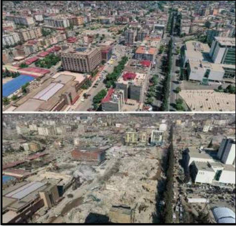
Şekil 2: Kahramanmaraş İl Merkezinin 2023 Şubat Depremleri Öncesi ve Deprem Görünümü
