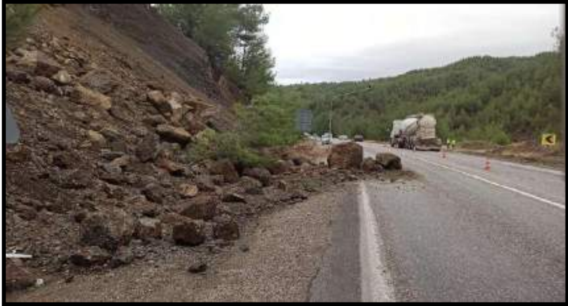
Şekil 7: Kayseri Yolu Andırın Kavşağı 05.1.2020 Heyelan ve Kaya Düşmesi
