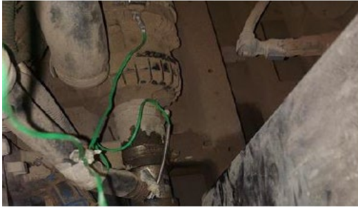
Şekil 4. Su Pompası Yüzey Sıcaklığı
