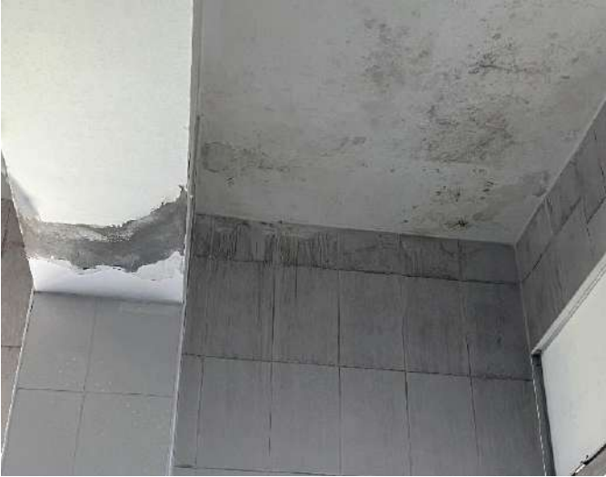
Şekil 2. Nemli yüzey ve küf (orijinal)
