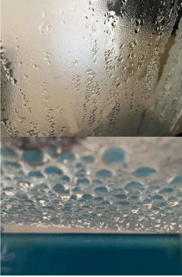
Şekil 1. Camlarda damlama (orijinal)
