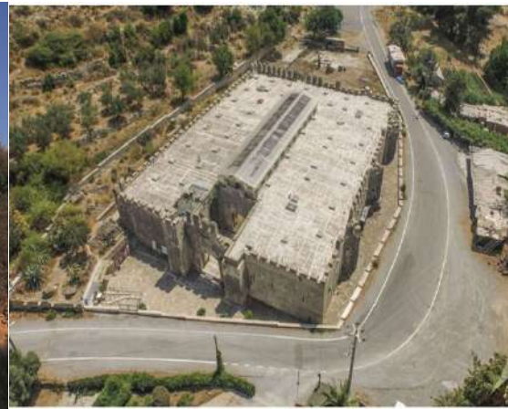
Resim 10: Alara Han'ın havadan görünüşü (https://www.kulturportali.gov.tr)
