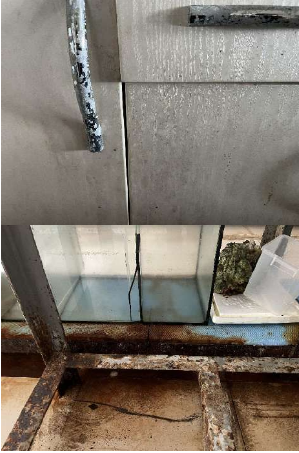
Şekil 3. Ahşap çürümesi, metal korozyonu (orijinal)
